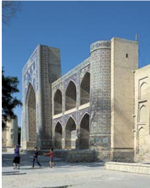
Fig. 17. Bukhara. Nādir Dīvān-Begī madrasa . (Photo: © UNESCO/A. Garde.)
